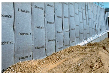
Enkadrain CL använt som dränering och vattentätning i samband med inrättande av källare
