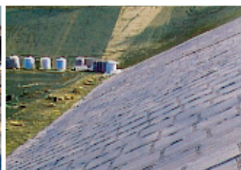
Enkadrain använt i ett avfallsupplag
