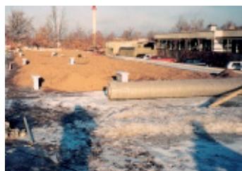
Enkadrain använt på takträdgårdar i Hörsholm i Danmark - rullbredd 5,0 m
