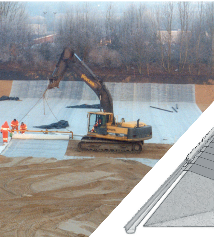
Billede 2 Manuel udrulning af membran
