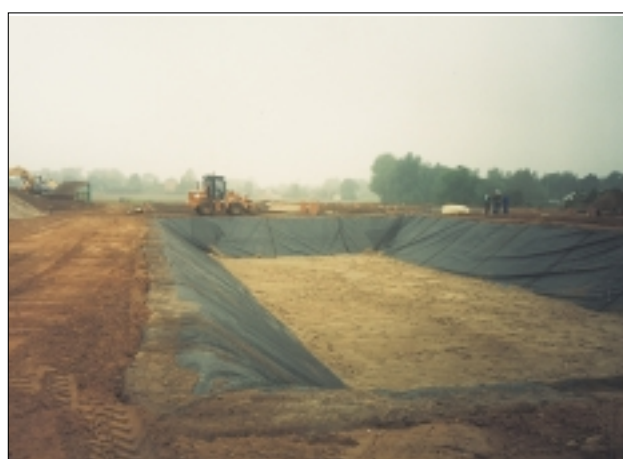
Fortrac geonet udlagt på geomembran som friktionsunderlag i slambassiner
