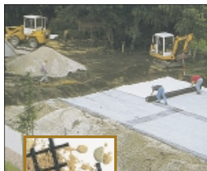
Effektiv fastlåsning af sandmaterialer i geonettet
