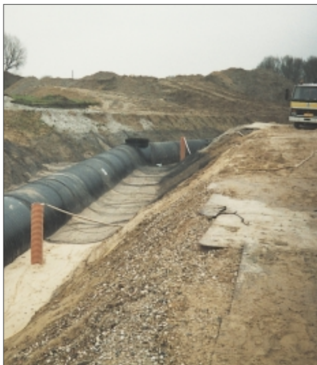
Ballastering af PEH-regnvandsledning i Utterslev Mose
