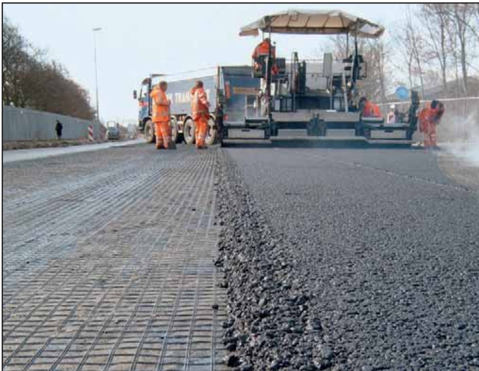
Udlægning af HaTelit® i Holland i 2002
