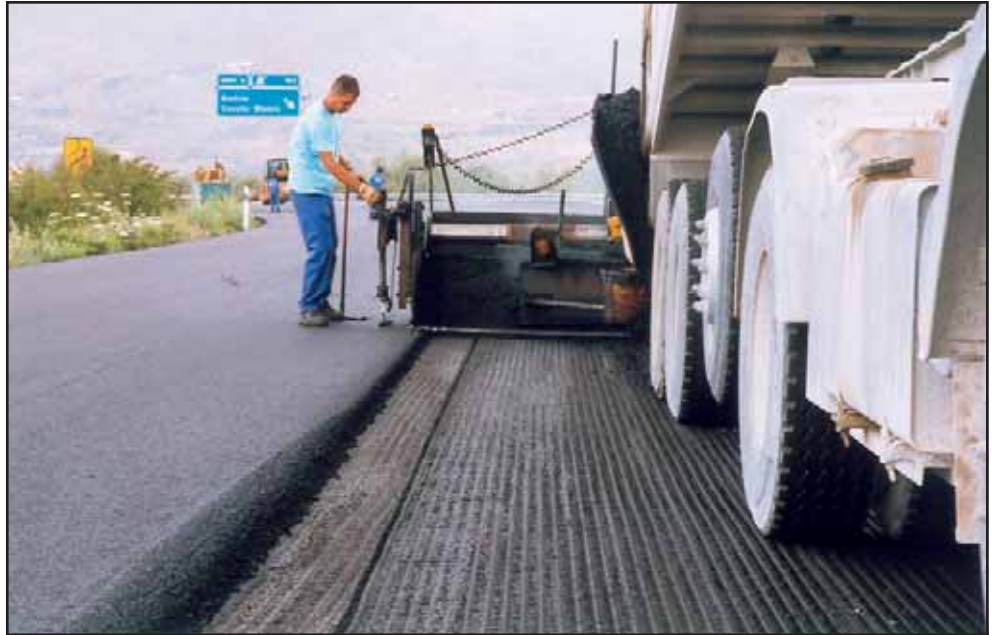
Udlægning af HaTelit® i Spanien i 1999
