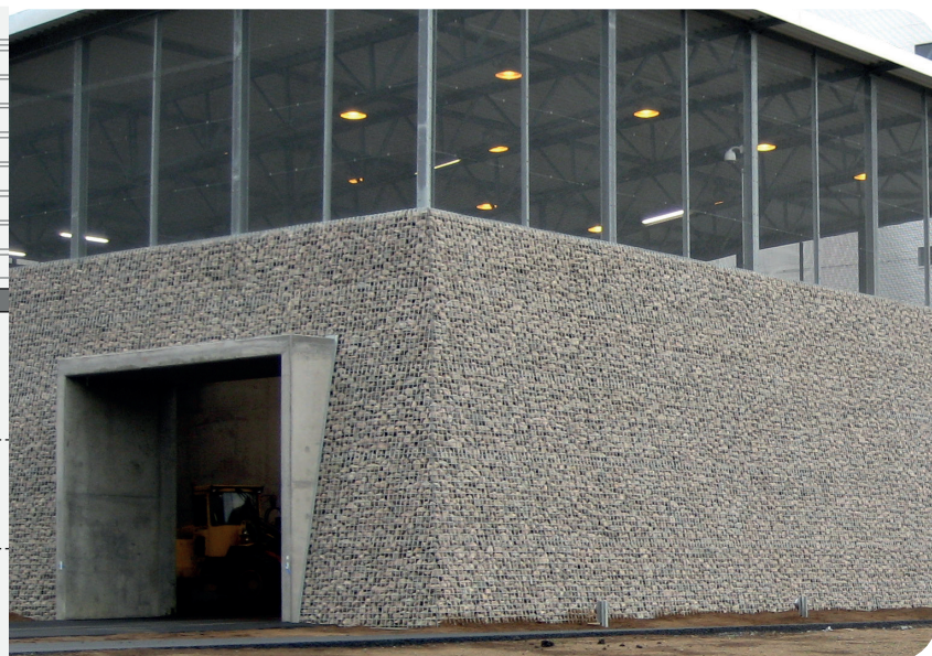
Vector Wall® gabionvæg fuldt integreret i øvrig bygningsværk. Jönköping Torsvik, Sverige.
